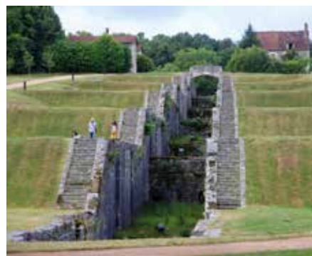
Den gamla trappan ersattes av 5 vanliga slussar i tätt följd. Därför hade vi 2 goa glada slussvakter med oss.
