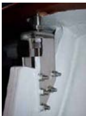
Röstjärnsinfästning med låsbrickor. Foto Sam Behrman.
