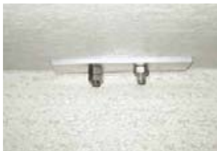
Pollarfäste under däck. Notera att en låsmutter saknas. Foto Ove Thorin.
