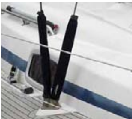
Vantskruvar skyddade med textilöverdrag. Lyft på överdragen ibland för att vara säker på att skruvarna är säkrade som de skall. Foto Ingemar Pålsson
