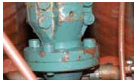
Kopplingsfläns med klämkoppling. Observera att bultarna skall dras med rätt moment! Foto Ingemar Pålsson
