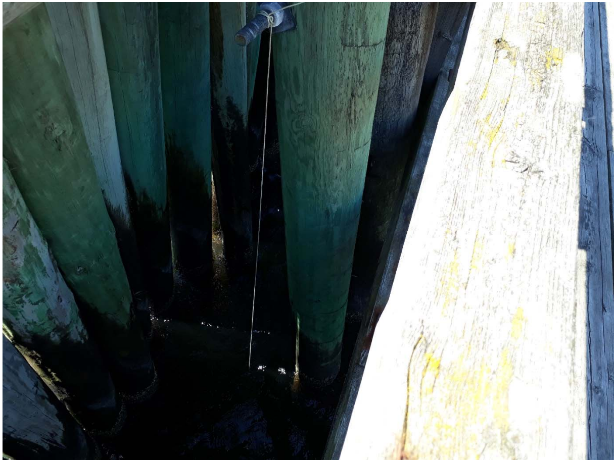
Figur 4. Tryckimpregnerade trästolpar vid i vågbrytaren, Hinsholmen. Båtplats X25 ligger strax innanför denna "pallisad".
