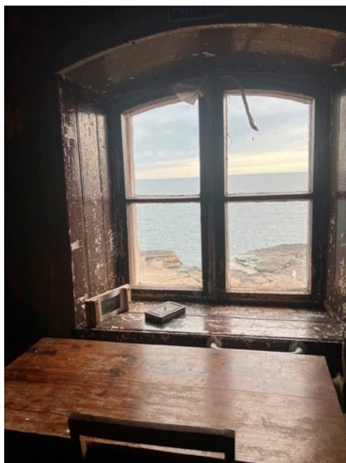
Fönster mot havet.
