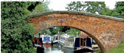
En typisk kanalbro
