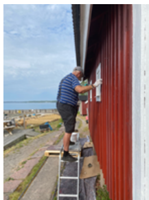
Åke lägger sista handen vid fönstret.
