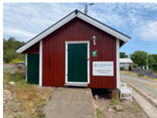
Entrén med nymålad fasad o ny skylt.
