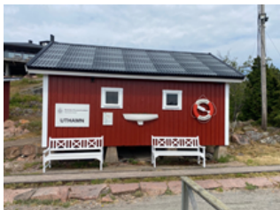
Fasad med informationsskyltar som vetter ut mot bryggorna
