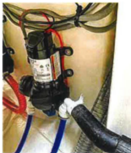
Bilden visar tryckvattenpumpens sugslang (blå slang) med en trasa runt - instoppad i våtdammsugarens slang (svart slang).
