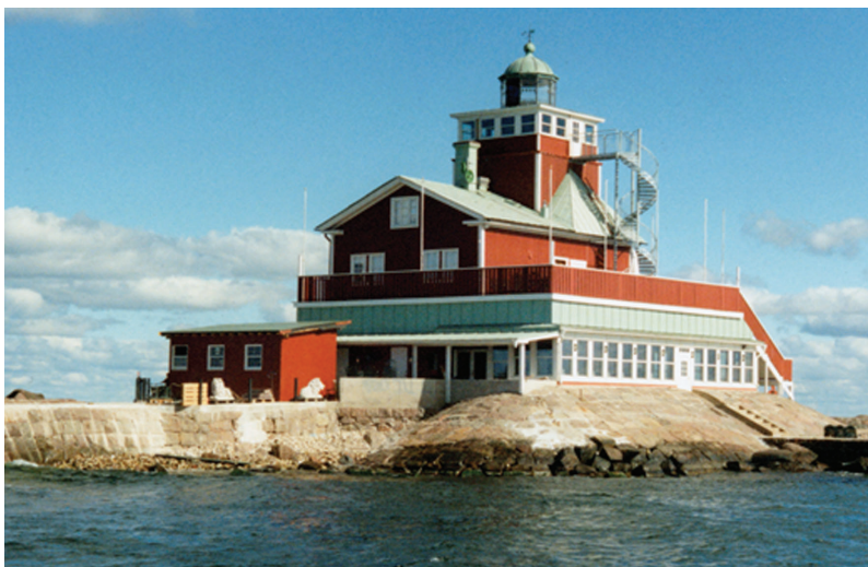
Dämmans fyr som konferensanläggning, restaurang och hotell.
