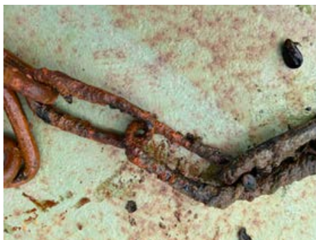
Kättingen strax under bojen. Hög tid att byta!
