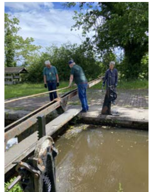
Problem med slussen vid Swanley Lock
