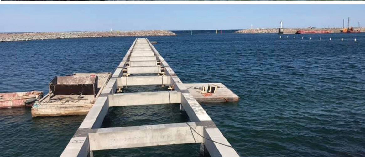
Bilder från bygget. Foto Borgholms kommun
