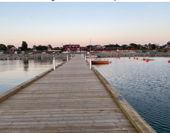
Den södra pålbryggan är färdig.
